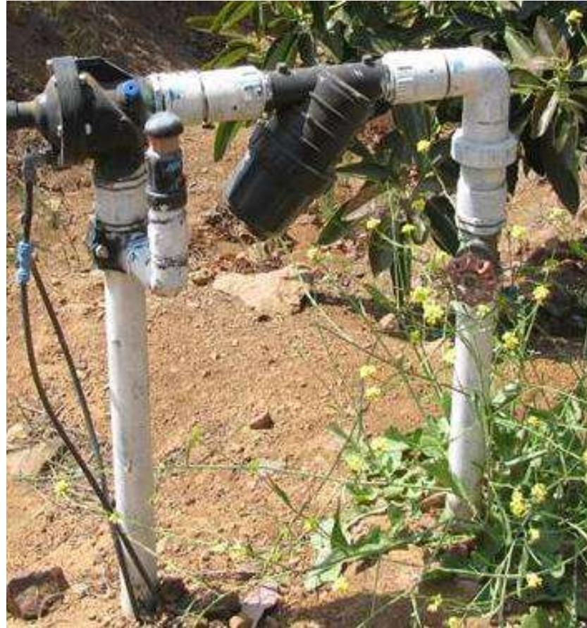
**Es un seguro para evitar el taponamiento por sedimentos físico que pueden ingresan a la red al romperse una tubería**
